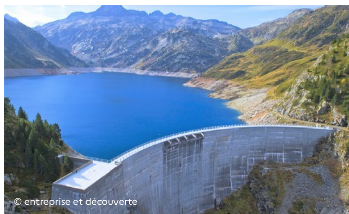
Barrage de Naguilhes alimentant la centrale d'Ascou, Hte-Ariège
