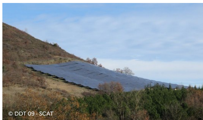
Parc photovoltaïque à Besset, Pays de Mirepoix
