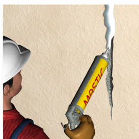
TRAITEMENT DES FISSURES (DTU 44.1)
